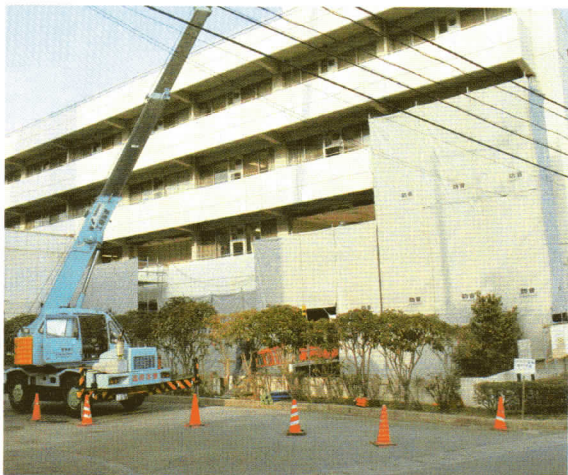
施設南面を改修している写真です。
